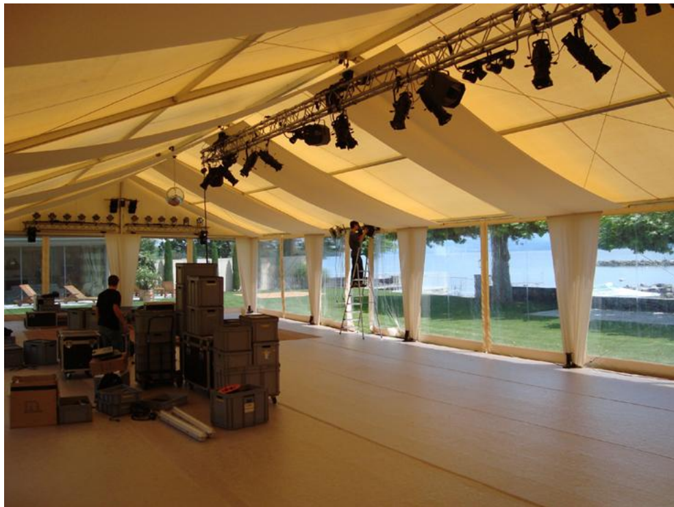
Lais de coton gratté, pose sous structure et devant poteaux
