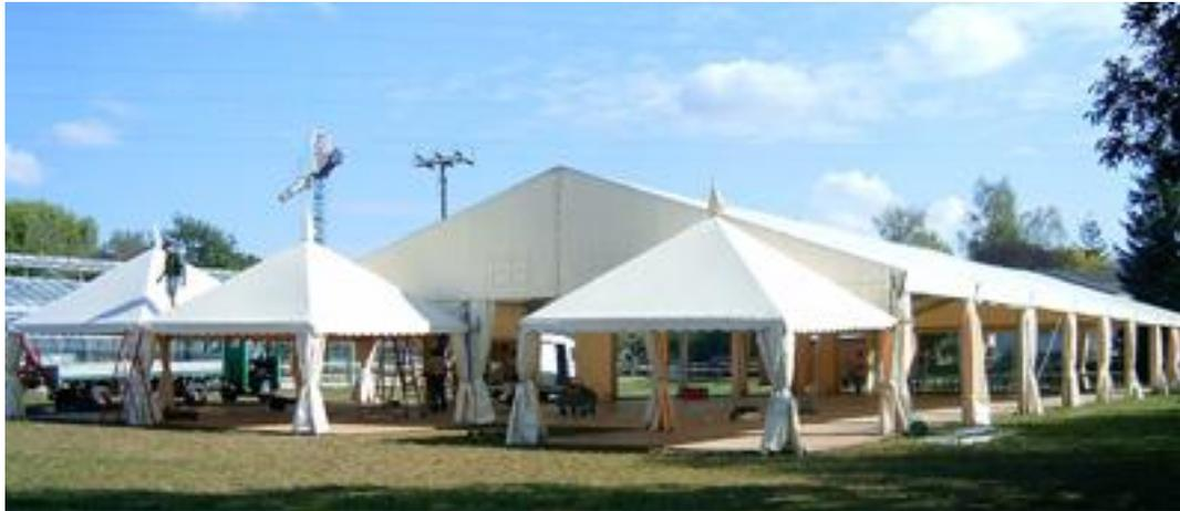
*Structure 15 m x 35 m, avec annexes de 5 x 5 m, surface utile de 525 m<sup>2</sup> + 75 m<sup>2</sup>*
