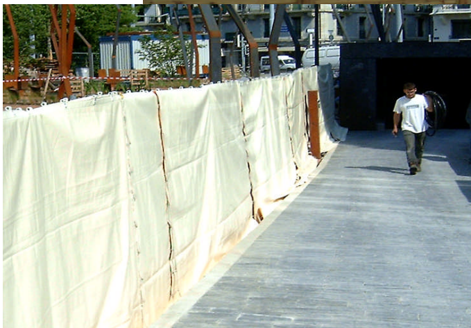
Habillage clôtures avec bâches même couleur que les tentes
