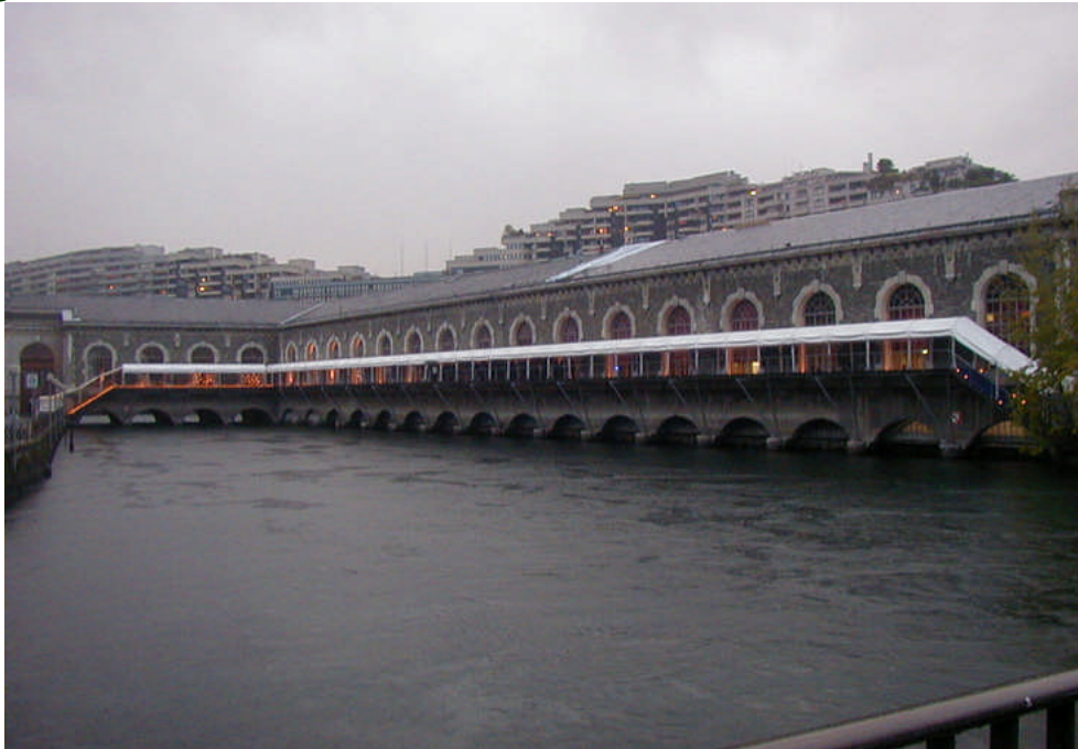
Passage couvert, liaison, montage en série, avec structures cintrées, blanc. Eléments de 2.00 x 3.00 m. Hauteur de passage mini 2.20 m
