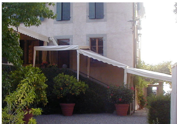
Passage couvert, liaison, montage en série, avec structures toit 1 pan, blanc champagne. Éléments de 2.50 x 3.00 m. Hauteur de passage maxi 2.10 m
