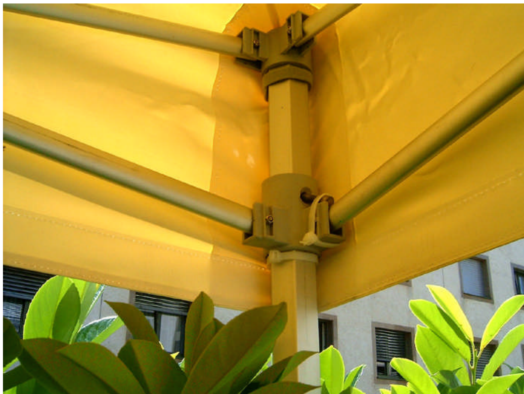
Détail de construction
