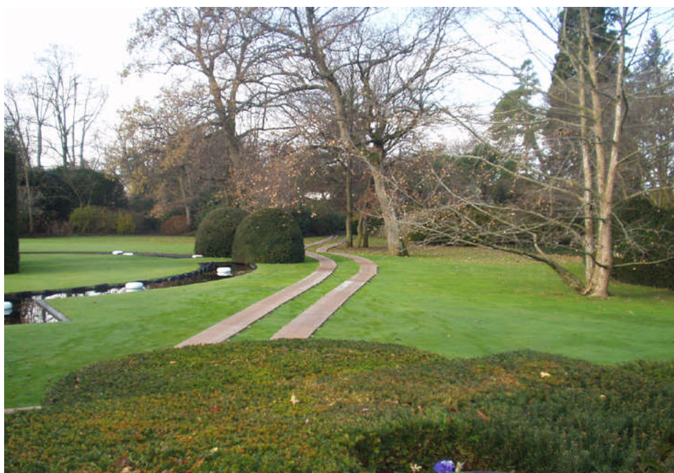
Chemin d'accès provisoire pour ne pas endommager le terrain lors du montage
