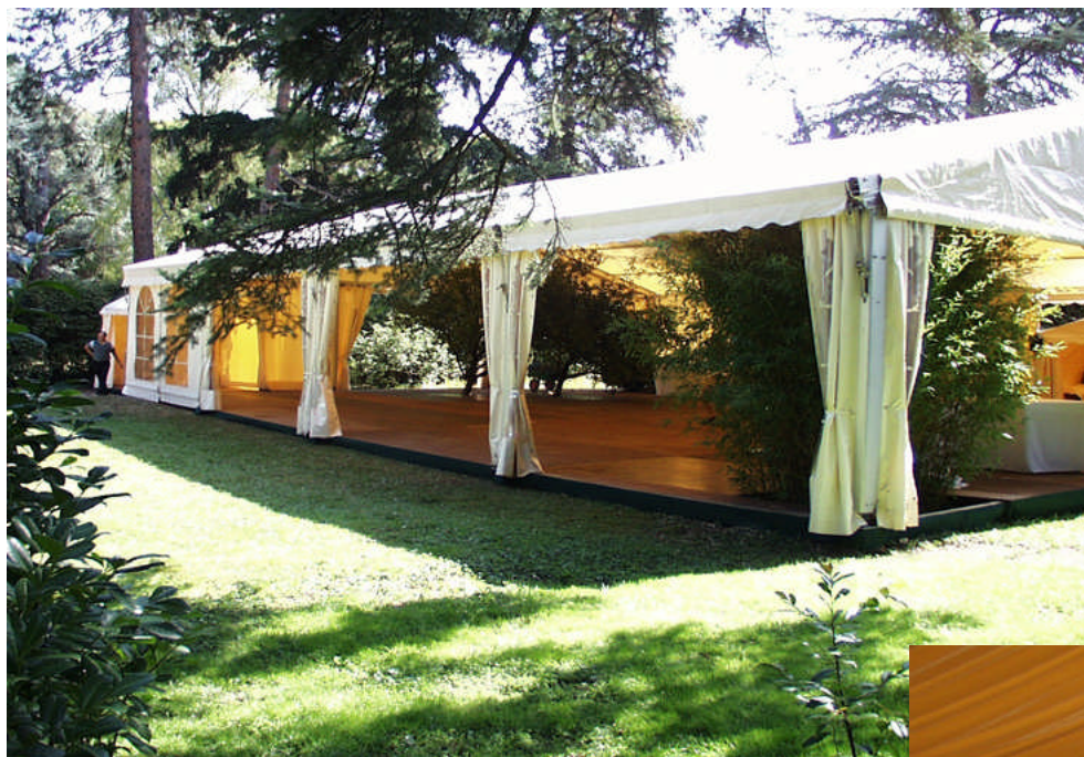
Tente intégrant des éléments naturels existants avec découpe du plancher autour des arbres et massifs
