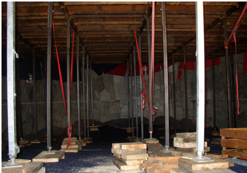
Pose d'un plancher sur une piscine intérieure
