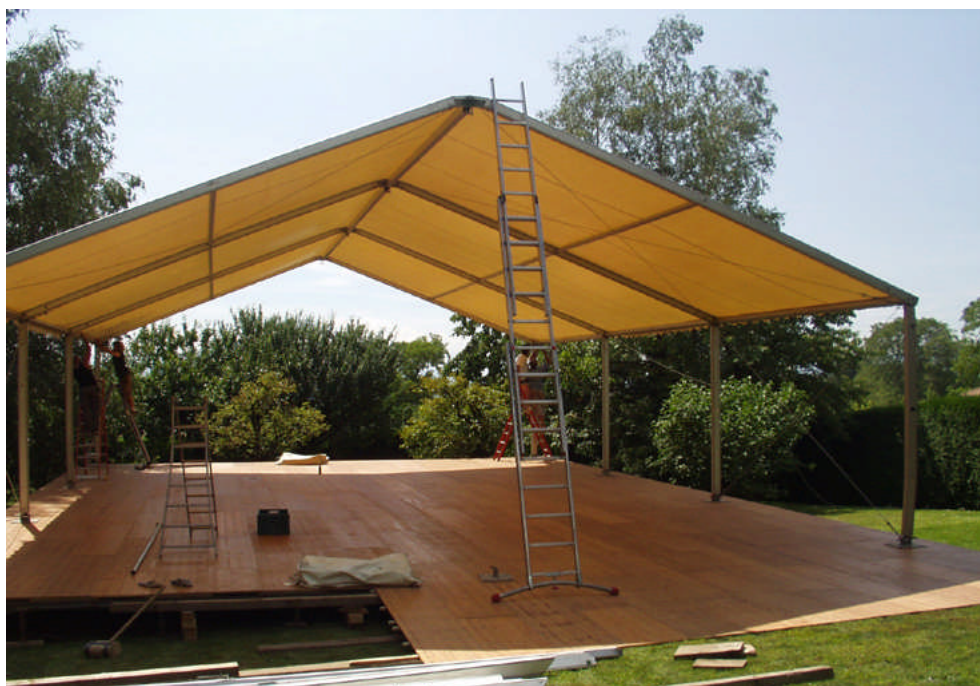
Pose du plancher bois verni destiné à recevoir la tente sur la structure métallique
