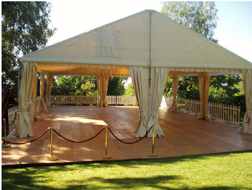
Montage de la tente sur plancher posé sur structure de calage
