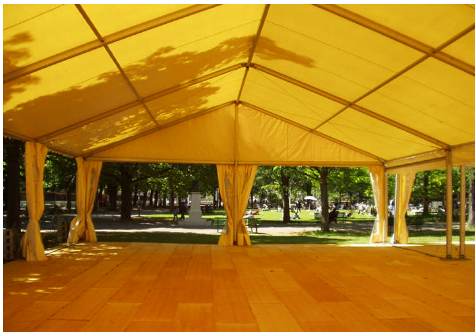
Plancher bois verni posé sur sol naturel, tente de 2 x 10m de portée
