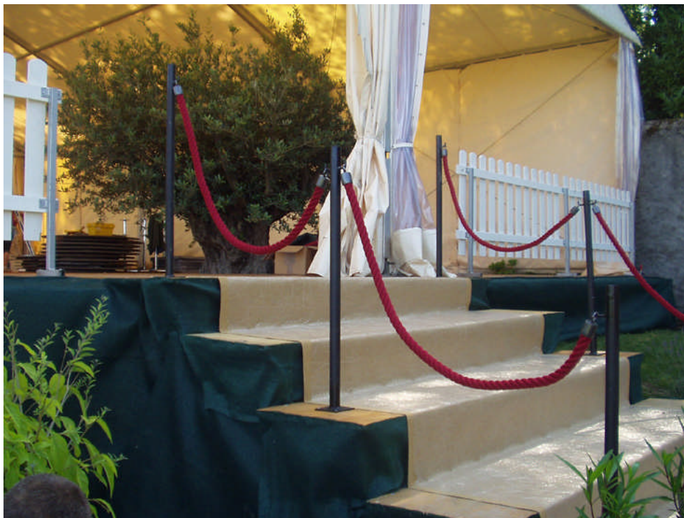
Escalier sur mesure en voie d'achèvement
