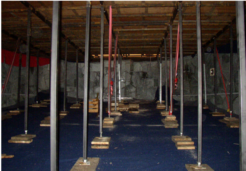
Pose d'un plancher sur une piscine intérieure
