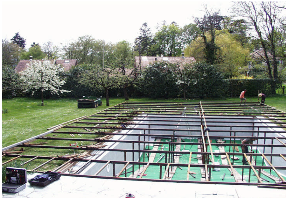
Pose de la structure métallique sur une piscine extérieure
