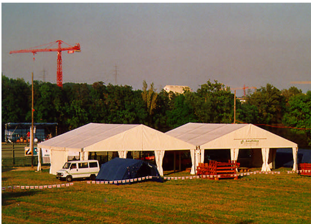
Structure 15 m x 15 m, montage côte à côte, surface utile de 450 m 2 , 30 m x 15 m
