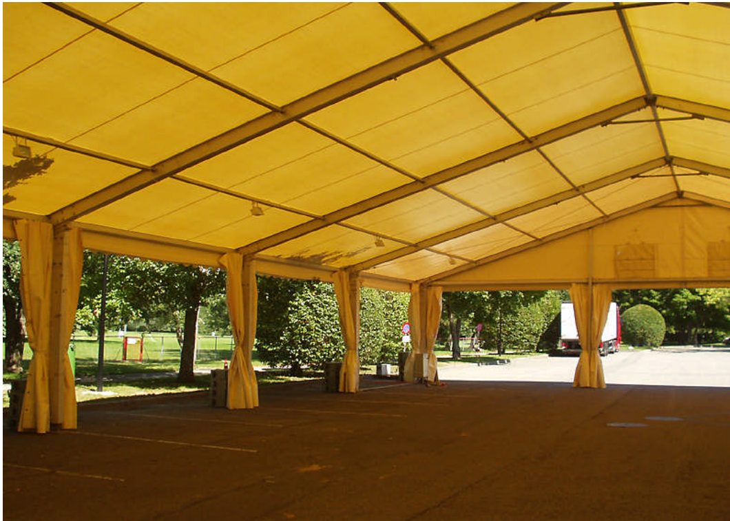
Structure 15m x 35 m, vision intérieure
