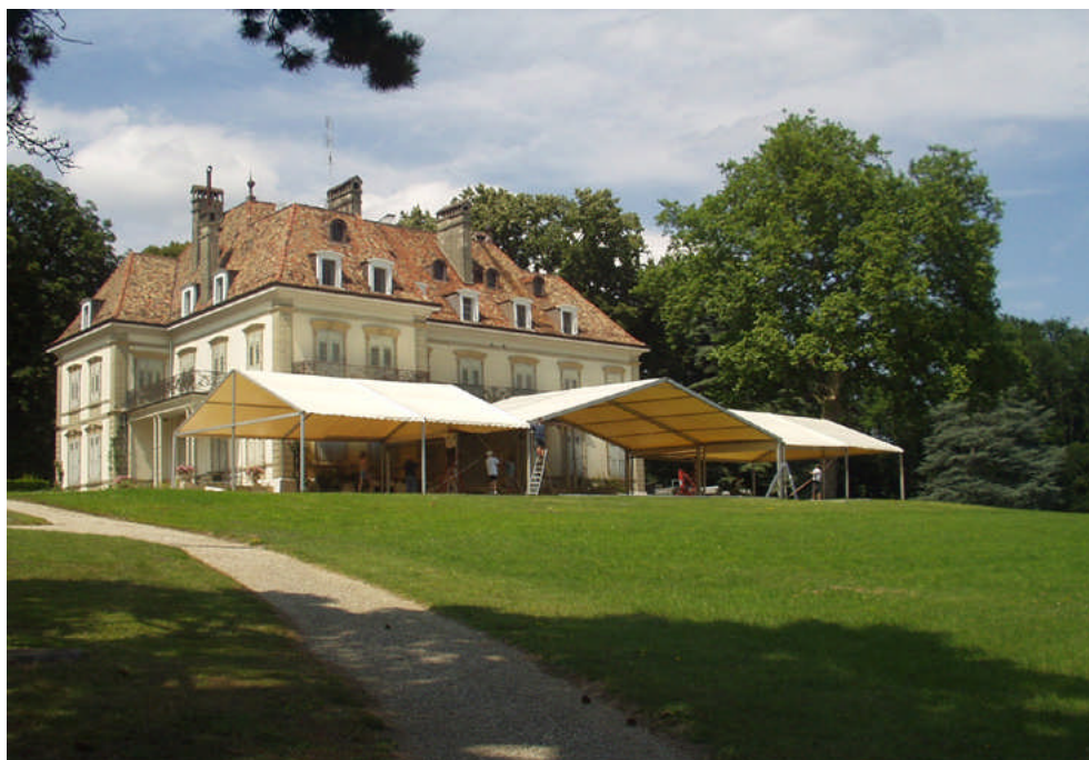
Structure 15 m x 20 m avec 2 structures de 10 x 20m sur les côtés, en cours de montage
