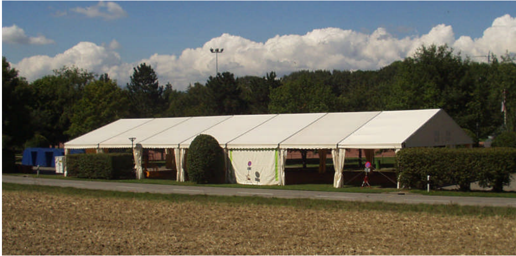
Structure 15m x 35 m, avec rideaux bâche pleine, surface utile de 525 m 2
