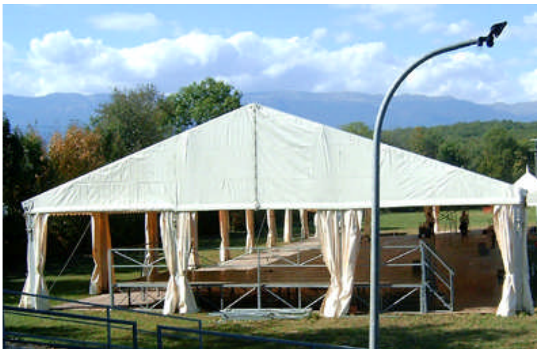
Structure 15 m x 35 m, pignon arrière ouvert
