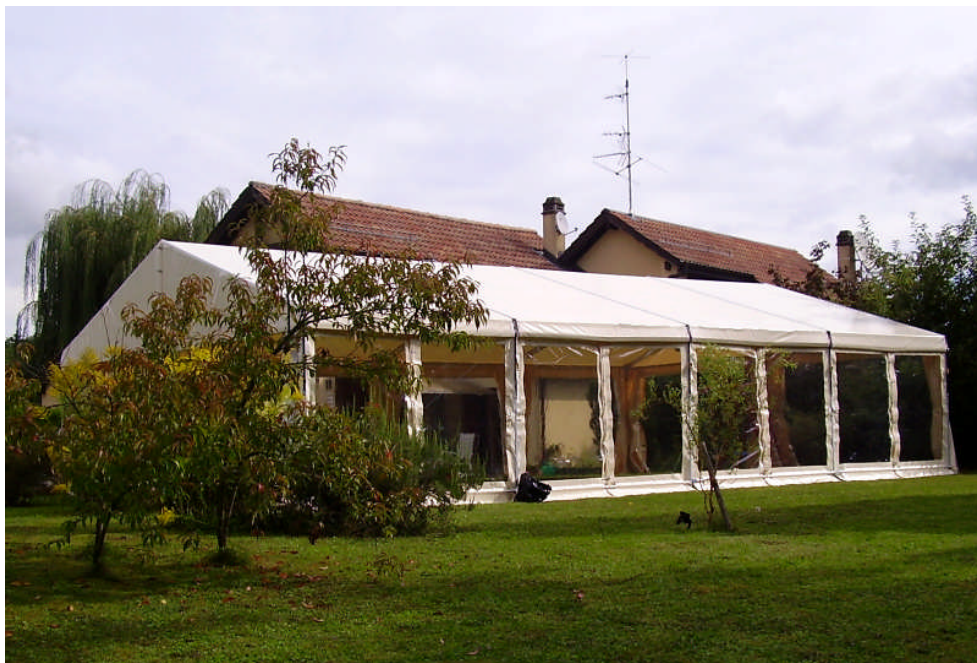
Structure 8m x 12 m ,avec rideaux cristal panoramiques
