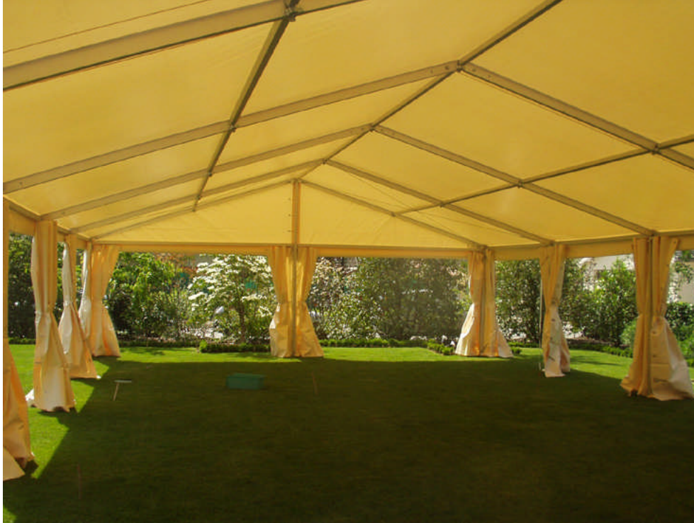
Structure 8m x 15 m, rideaux ouverts
